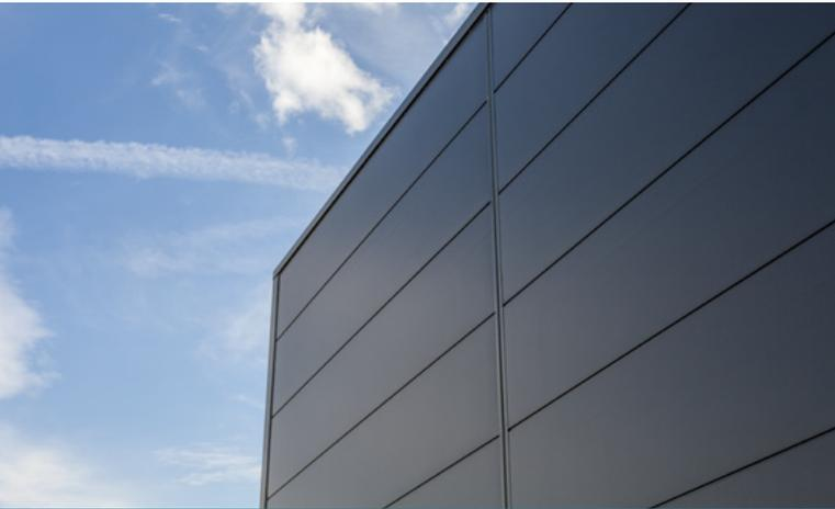
Panel de fachada con doble revestimiento metálico en espuma de poliuretano o poliisocianurato. Su característica principal esta en la fijación y tornillería pasante oculta.
